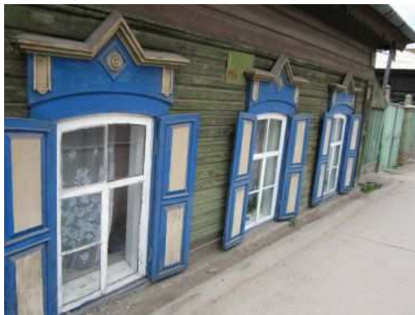
Auf „Sand“ gebaut: Manche Holzhäuser versinken im Boden. Bild: Fürnhammer
